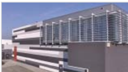
Главный производственный корпус завода FirstLine в г. Алкен, Бельгия
