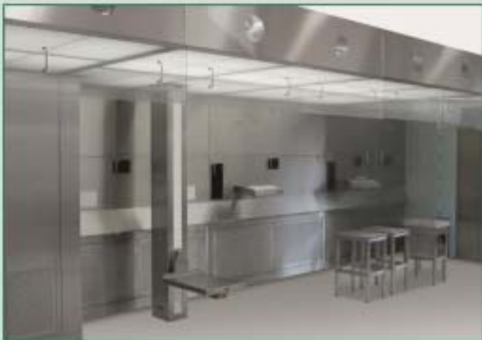
Ламинарное укрытие для взвешивания компонентов
