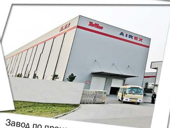
Завод по изготовлению автоматических систем загрузки и разгрузки (ALUS)
