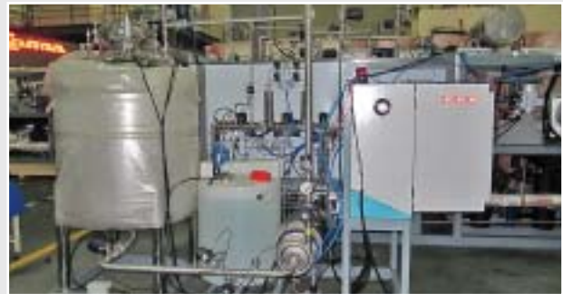
Внешняя система CIP, изготовленная Tofflon по заказу ООО «НПО Петровакс Фарм»
