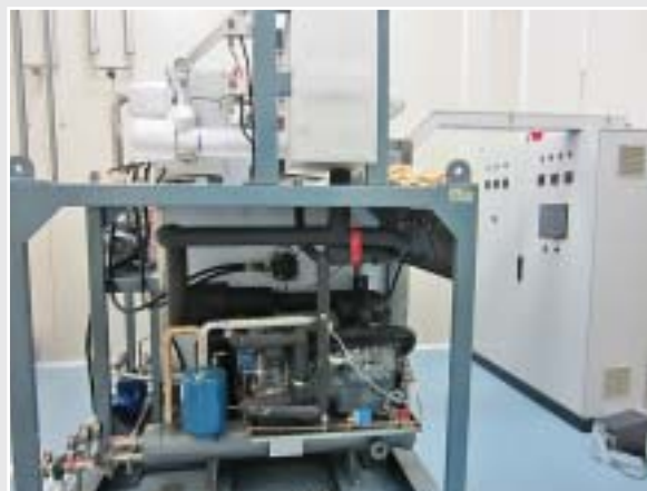
Установка Lyo-5 (SIP, CIP). Система циркуляции теплоносителя
