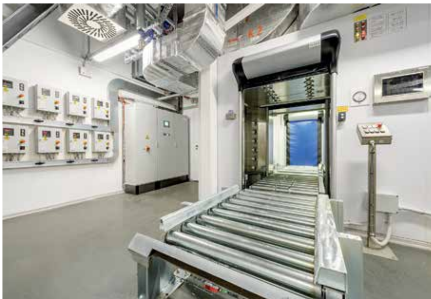
Рис. 2. Обдувочный материальный шлюз
