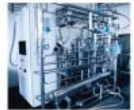
Станции CIP / SIP
