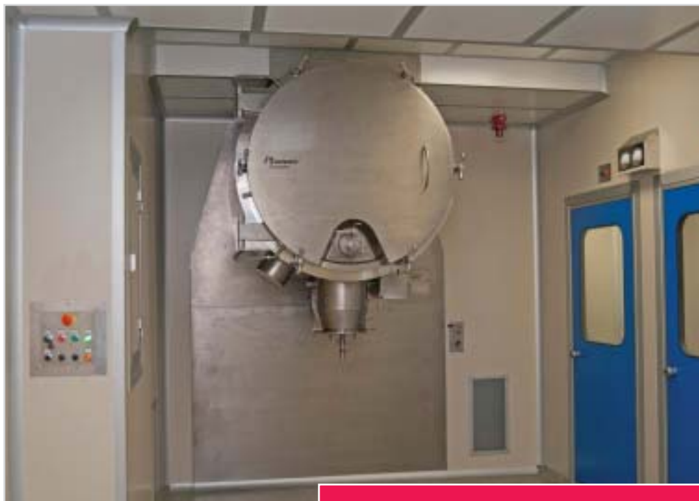
Монтаж системы PLANEX в чистом помещении
