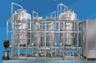
Генератор очищенной воды
