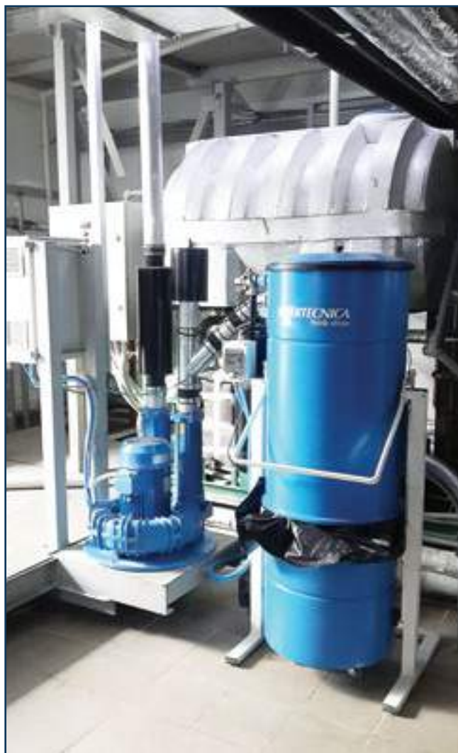
Силовой агрегат и сепаратор пыли, рассчитанный на 11 вакуумных розеток (при 5 одновременно работающих)
