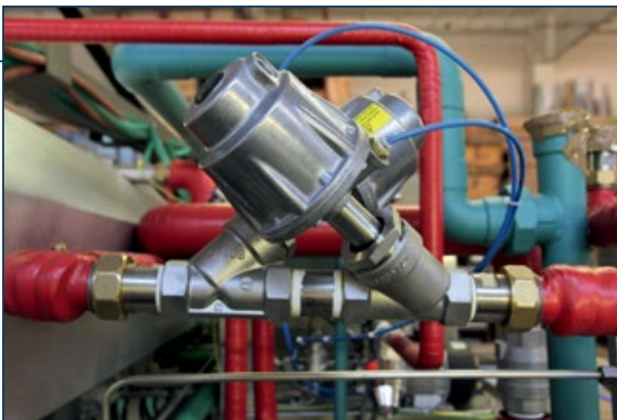
Рис. 3. Исполнение запорных вентилей и элементов трубной обвязки в лабораторных стерилизаторах
