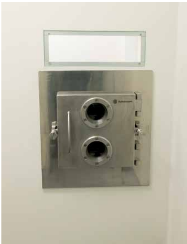
Двухкамерный шкаф LaboDry в Институте органического синтеза в Риге
