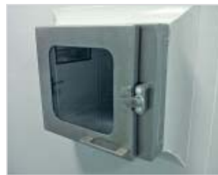
Рис. 5. Материальный шлюз для передачи материалов
