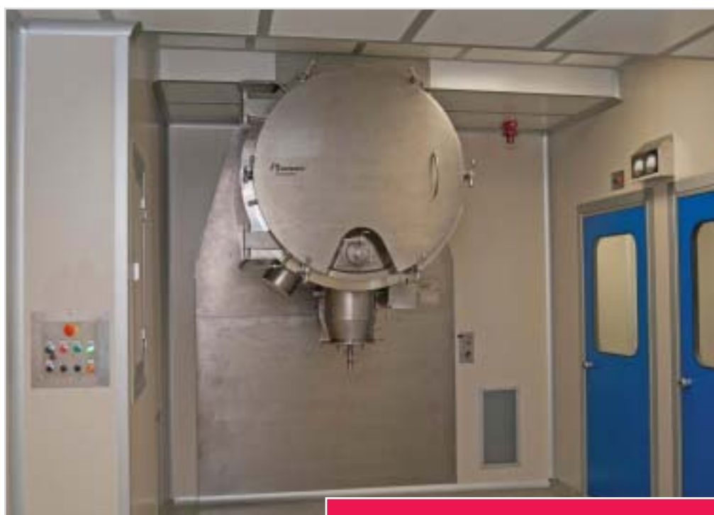
Монтаж системы PLANEX в чистом помещении
