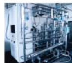
Станции CIP / SIP
