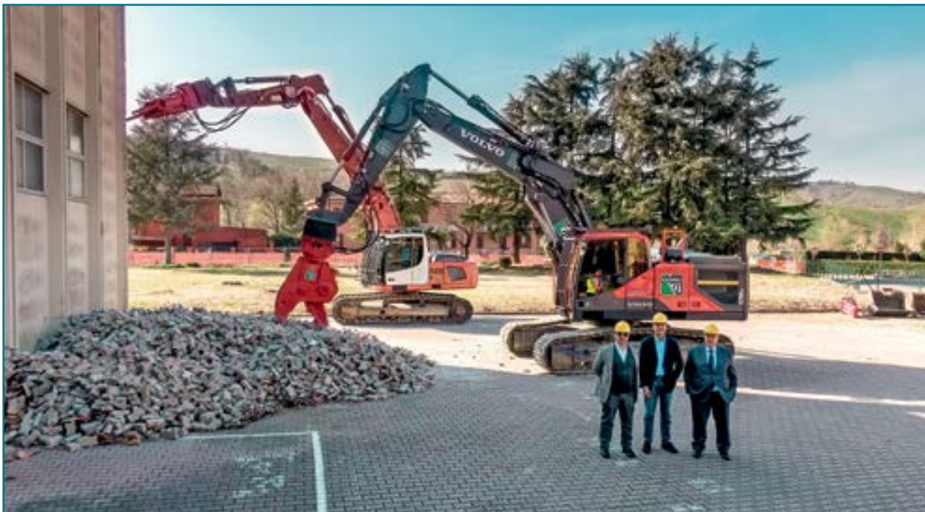
Реализация проекта, как и создание нового «подразделения красоты», началась в мае с закладки фундамента для здания нового офиса и производственной площадки
