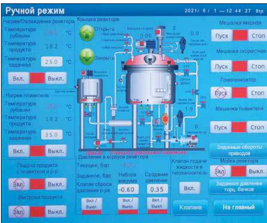
Панель PLC пульта управления
