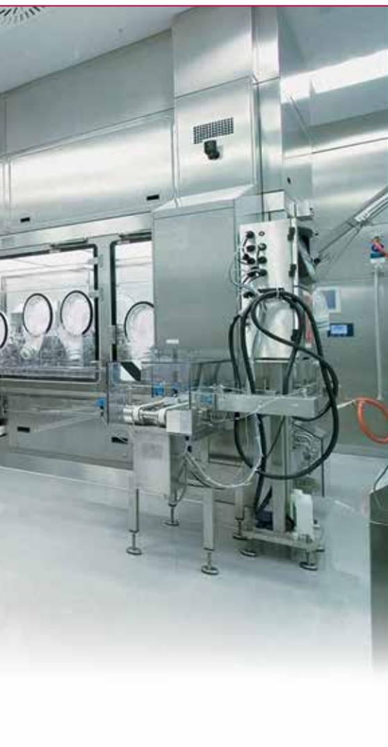
но никогда одновременно. Это гарантирует, что на каждую форсунку  $H_2O_2$  подается под определенным и постоянным давлением. Объем введенного в изолятор  $H_2O_2$  измеряется датчиком и регулируется открытием и закрытием клапанов, поэтому является определенным и контролируемым показателем. Данная система деконтаминации может быть укомплектована такими дополнительными функциями контроля, как проверка на герметичность и расход протекающего вещества ( $H_2O_2$ ).
